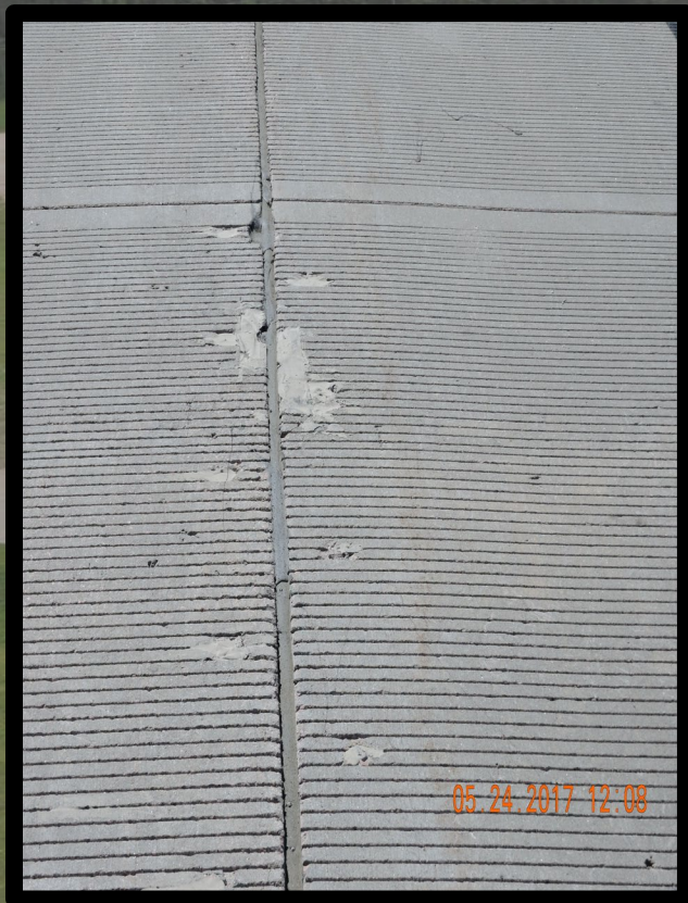
Spalling
