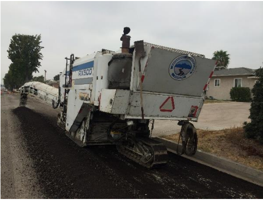
Step 1. Edge milling.
